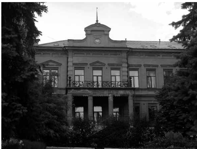
Дом П.П. Шмидта (ныне Саратовский областной колледж искусств). Архитектор А.М. Салько. Фото Анны Морковиной
